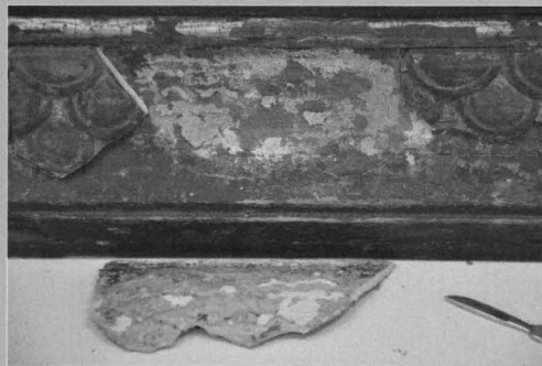
Detalii privind degradarea și pierderea stucaturii Details regarding the degradation and loss of stucco
