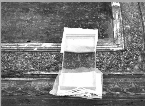
Detalii ale etapelor de lucru privind curățirea, încleierea și fixarea stucaturii Details of working stages on cleaning, gluing and attaching stucco
