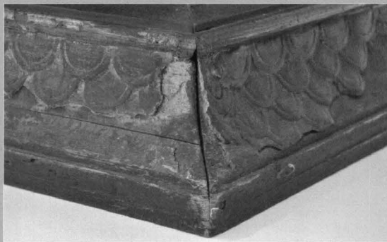
Detalii privind degradarea și pierderea stucaturii Details regarding the degradation and loss of stucco
