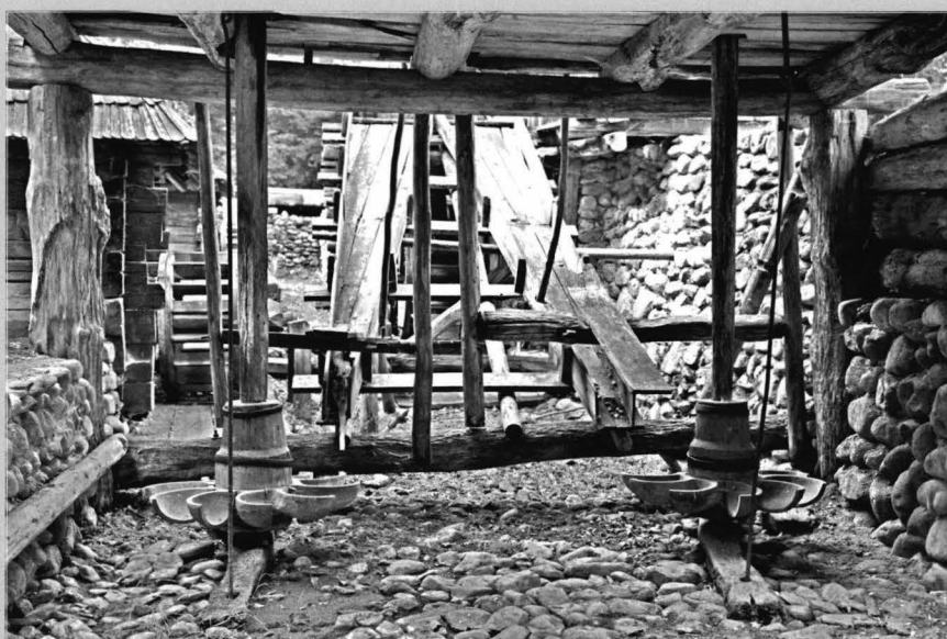
Instalația hidrotehnică și cele două ciuturi ale morii din cadrul Complexului de industrii populare din Polovragi, jud. Gorj
