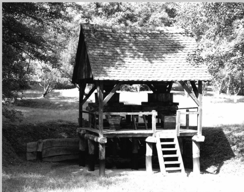
Moara cu două ciuturi și angrenaje de transmisie, Râu de Mori, jud. Hunedoara Watermill with two horizontal wheels and gearing, Râu de Mori, Hunedoara county
