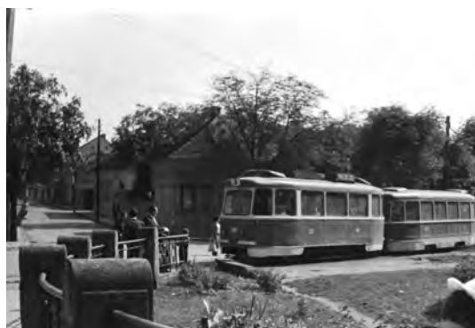
Fig. 9. Primăvara anului 1981: garnitură ITB, circulând spre Zona de Vest (Cartierul Rogerius) trece în dreptul capătului Podului Decebal, de pe malul drept al Crișului Repede. Puntea în sine se afla în proces de demolare, ca urmare a avarierii sale în martie a aceluiași an 64 . (Sursa: Nagy István)
