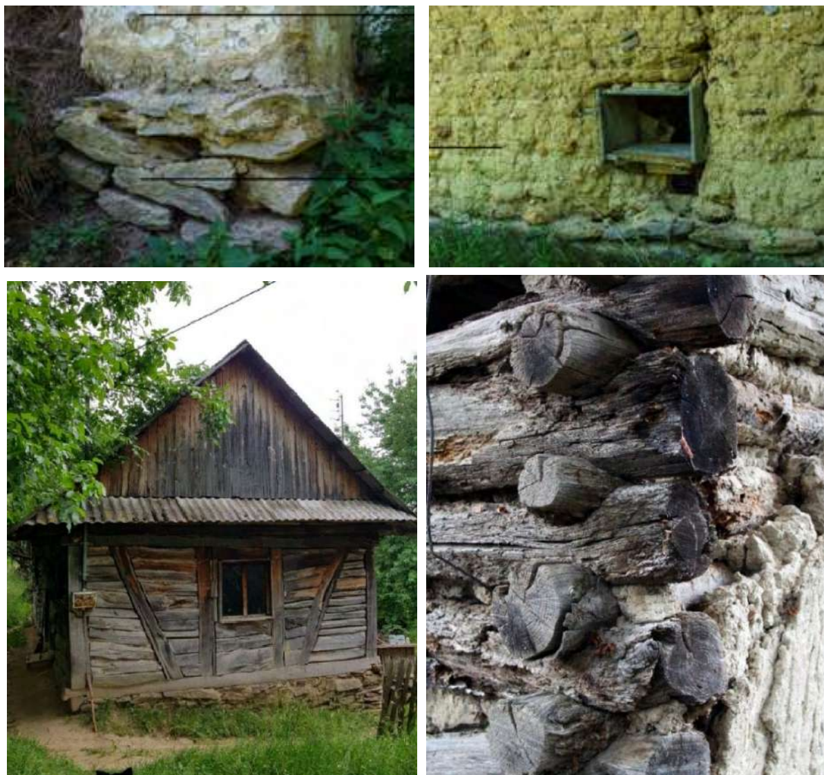
Ilustr. 3. a, b, c, d. Tehnici de construcție: tehnica șoșilor-stânga jos, tehnica sulelor-dreapta jos, tehnica pământului călcat-stânga sus, tehnica pereților de voioagă-dreapta sus (foto: Ioana Blajec)
