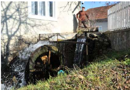
Foto 1 – moară de apă cu aducțiune superioară, Hălmăgel (jud. Arad)
