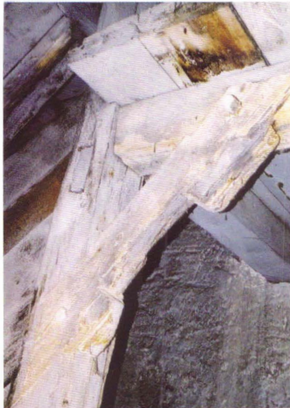
Fig. 13 Coroziune micotică a lemnului – tronson C
