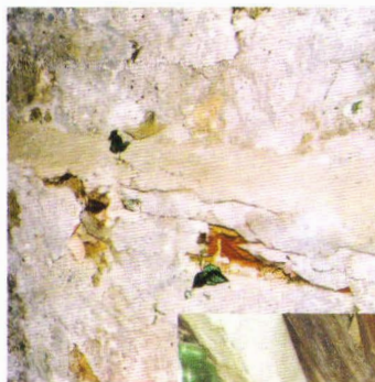
Fig. 9 Fisuri și burdușeli ale zidăriei provocate de umezeală și vegetație – tronson C
