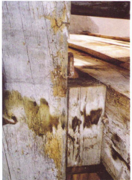
Fig. 14 Atac de insecte Anobidae și ciuperci care produc modificări cromatice – tronson A
