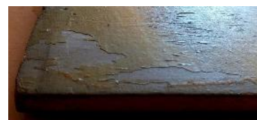
Fig. 3-5. Imagini de detaliu reprezentând degradări cu tendință evolutivă, concretizate prin desprinderi și pierderi de strat pictural.
