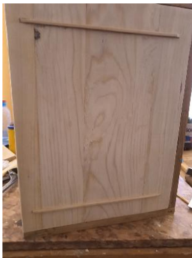
Fig. 14. Reconstituirea panoului glisant.
