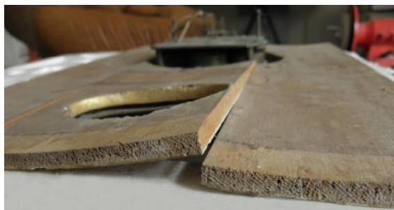
Fig. 9. Modificări de planeitate între elementele panoului frontal.
