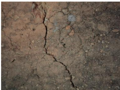
Fig. 7-8. Aspecte ce scot în evidență fisurile și exfolierile pereților.
