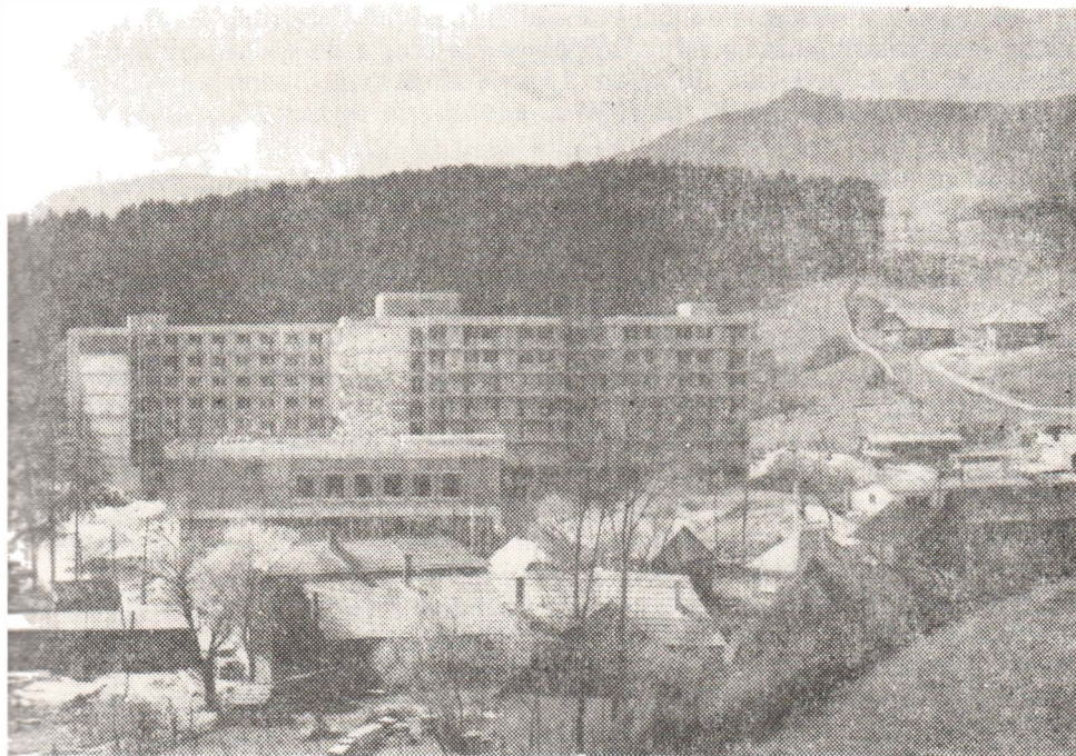
Fig. 5. — Complexul balnear de 900 locuri Sîngeorz Băi.
