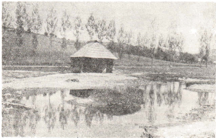
Fig. 4. Cepari — Fîntînă cu apă sărată acoperită de o construcție din lemn.
