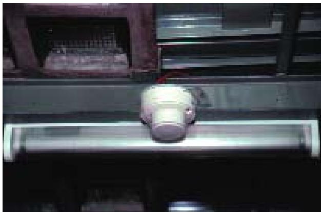
20. kép UV szűrővel ellátott világítótest és füstérzékelő
