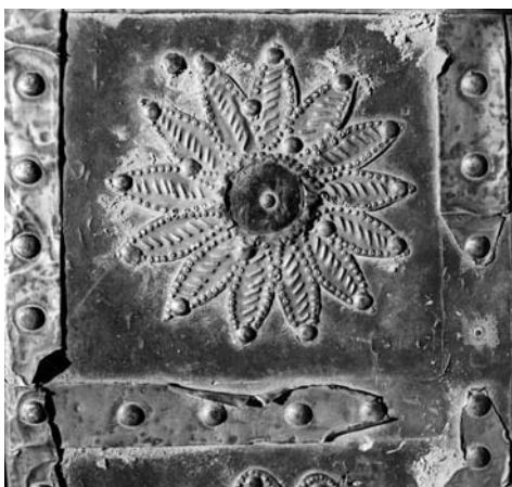
15. kép. Sérült, hiányos, szennyezett rézlemez a tetőn
