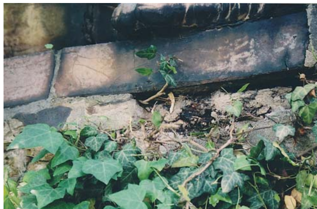
7. kép. Az borostyán erős gyökérzetével és kacsáival szétfeszíti a kerámia elemeket
