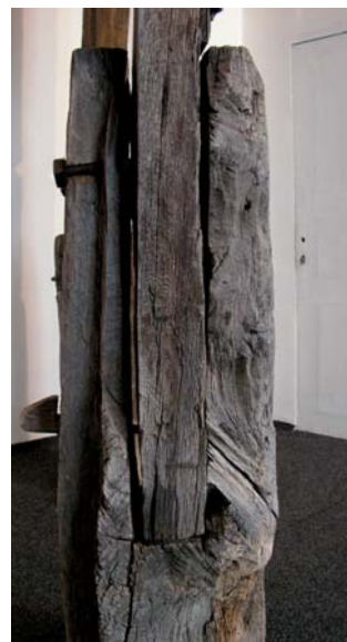
12. kép. A középső zábé ráklábázása, a kapuszerkezet zárának maradványával.
