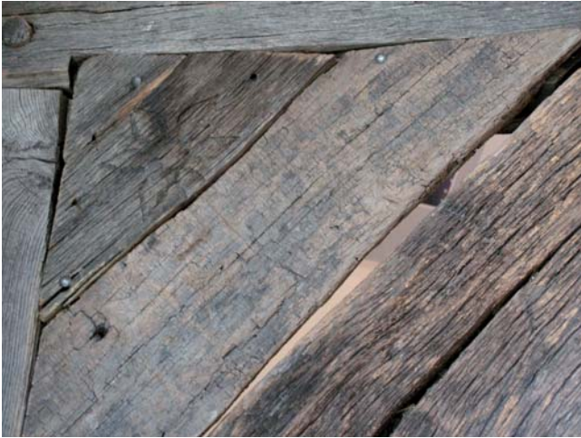
9–10. kép. A nagykapu bal oldali hónaljkitésének kiegészítés szemből és hátoldról.
