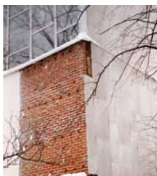
6. kép. A Finlandia palota részlete a márvány burkolat eltávolítása után. Látható az eredeti szerkezet, és az is, hogy a burkolat ennek minden jellegzetességét figyelmen kívül hagyja.
