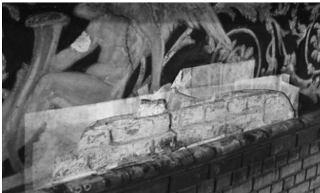
26. ábra. Andrassy út 102. A freskó egy részének „stacco” technikával történt leválasztása és a meggyengült alsó vakolat eltávolítása után előtűnt a károsodás egyik oka, egy feltehetőleg aktív szerkezeti repedés.
