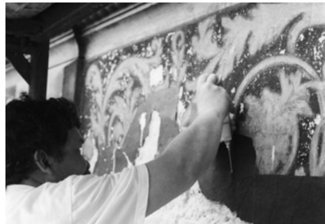
24. ábra. Bajza utcai homlokzat: injektálás meszes-ammónium-karbamátos anyaggal. A japánpapíros átragasztsás két okból volt szükséges: azért, hogy az elvált vakolat ne essen le, és hogy a festést védjük a kifolyt injektáló-anyagtól. (Gyöpös Miklós)
