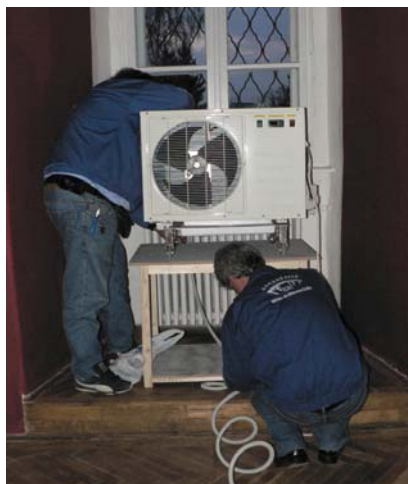
6. kép. Párátlanító gép beszerelése.
