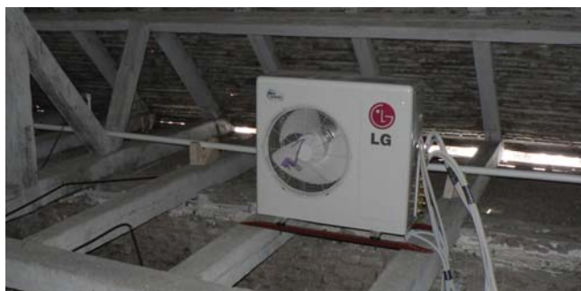
5. kép. Klimaberendezés kültéri egysége, a padlástérben.
