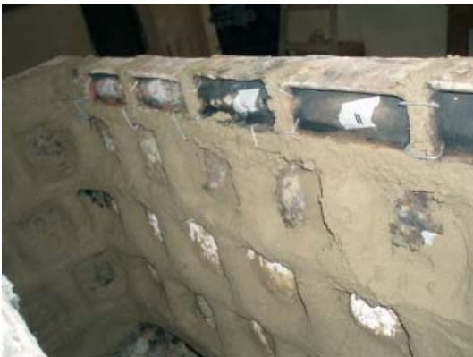
24. kép. Az eredetinek megfelelő bordakiképzés az összeépítés során.
