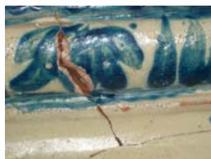
15–16. kép. Párkányelem ragasztása és tömitése.
