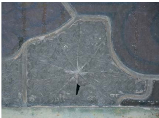
7 kép. A fémcsodrony nem véd meg a lőfegyverektől. Kalocsa, székes-egyház.
