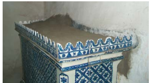
28. kép. A restaurált kandalló füstfogója.
