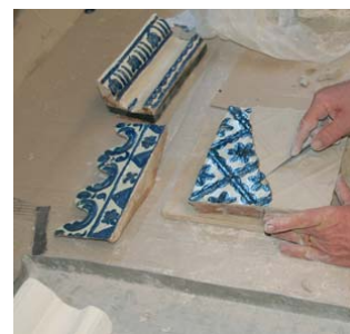
18-19. kép. A hiányos csempelapok kiegészítése tűzálló agyaggal.
