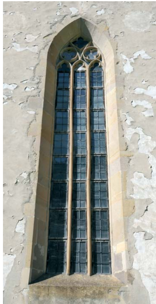
32. kép. A késmárki templom egyik gótikus ablaka több száz éves ablakelemekkel és beépítési megoldásokkal.
