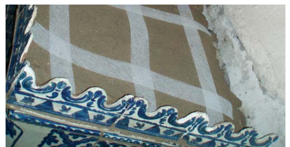
27. kép. A tető megerősítése üvegszálas szövettel.
