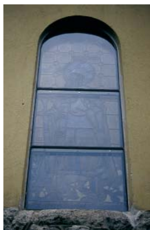
14. kép. Védőüveggént a legjobb megoldás a sima felületű ragasztott biztonsági üveg. Zebegényi templom, 2008.
