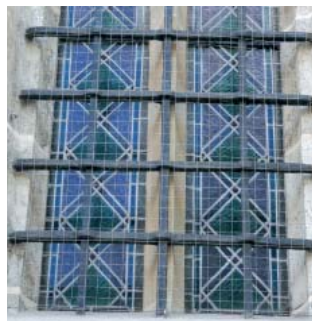
26. kép. Kovácsoltvas fémrács madárhálólal kombinálva mérnöves ablakbélletben.
