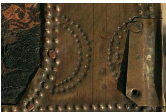
23. kép. A bemélyedő pontsorokat karc jelöli ki a lemez színoldalán és megfigyelhető a borítólemez javítása is, a hiányzó szegecsnél, a szegecs kör alakú helyét egy lyukasztóval ütötték ki. 1856 Pest, Magántulajdon
