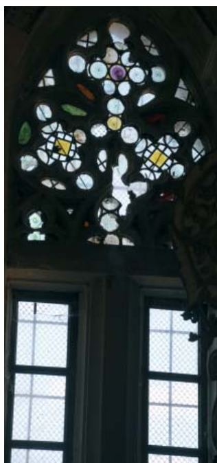
19. kép. A szászivánfalvi templom ablakának felső része a belső oldalról. A szétesés határán lévő üvegeket csak a sodronyok tartják a kizuhanástól.
