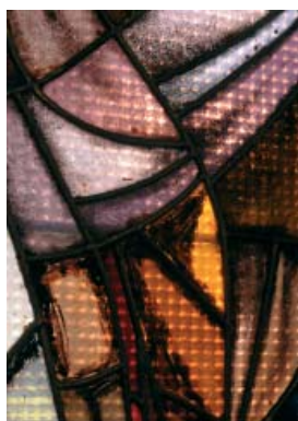
13. kép. A drótbetétes üvegek pointillista fényei megzavarják az üvegfestmények esztétikai hatását a belső oldalról is. Budapest, Városmajori templom.
