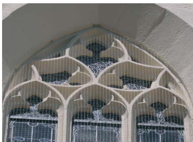
25. kép. A faragott kőkeretes ablakoknál a madarak elleni védekezés egyik legjobb módja a vékony madárháló.
