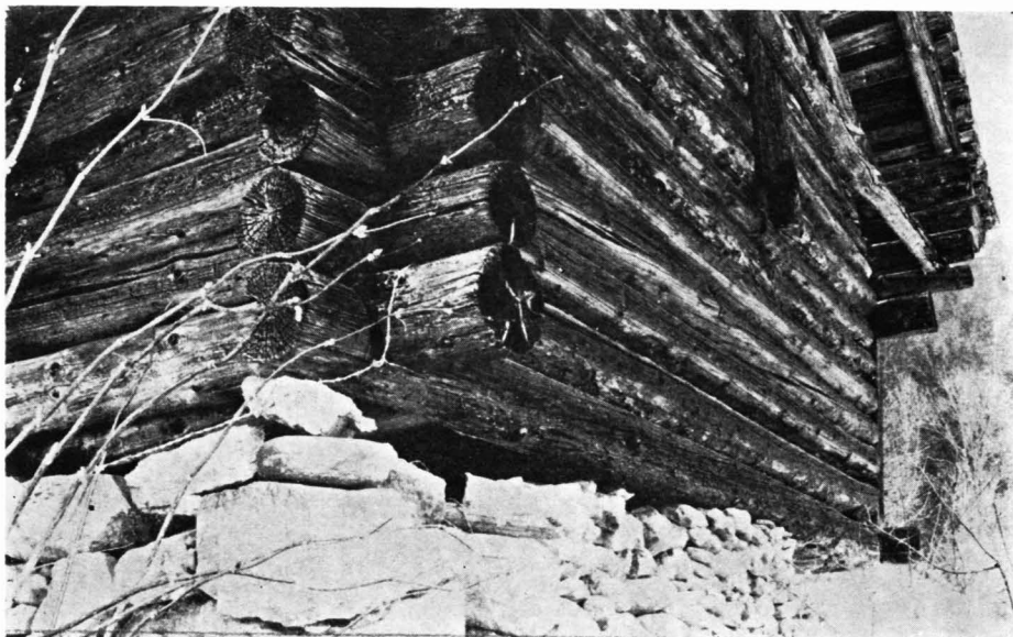
Fig. 3. — Écurie-grange: poutres rondes, assemblage « en coches ». Les Ormonts.
