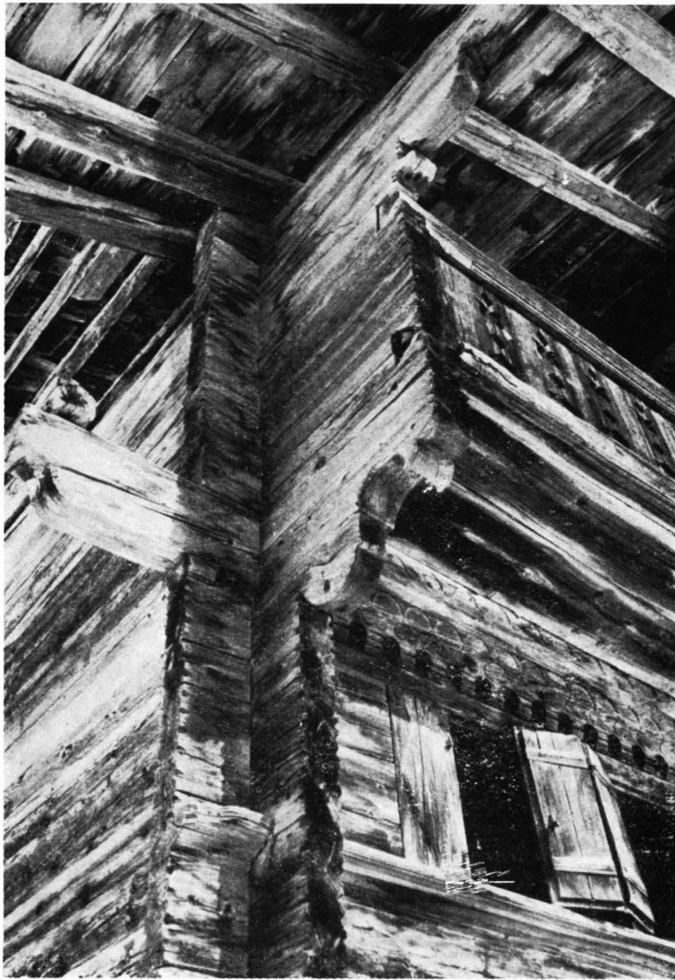
Fig. 7. — Détail: Blockbau et décor taillé.
