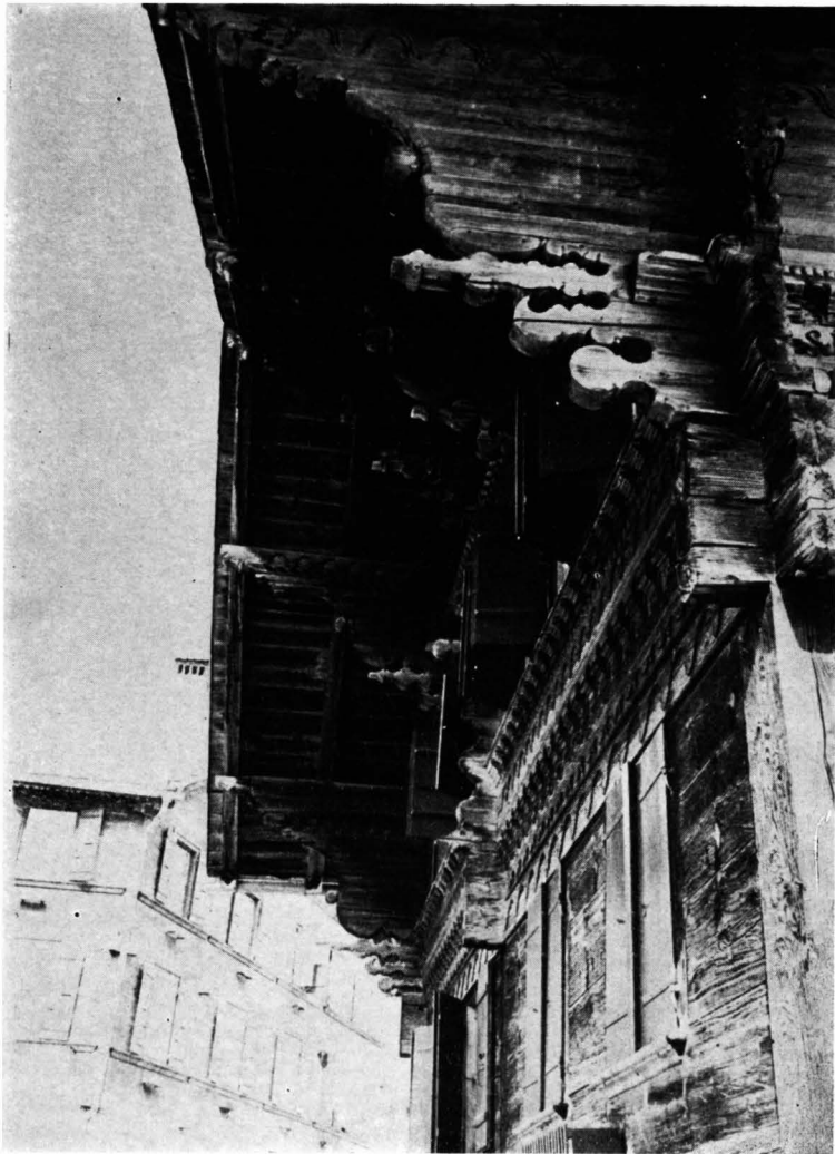
Fig. 4. — Technique mixte: Blockbau + Ständerbau. Pays d'En-Haut.
