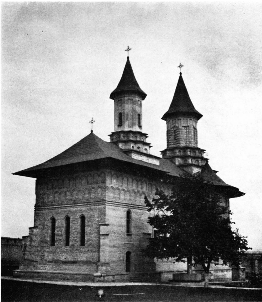
Fig. 19. — L'église du monastère Galata, Jassy; après la restauration de 1961 — 1971.
