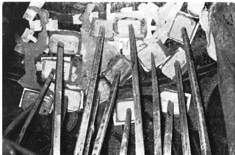
Fig. 30. — L'église de l'ancien monastère de Humor (départ. de Suceava); la consolidation où s'était produit un détachement de la couche-support d'une certaine étendue (1972).
