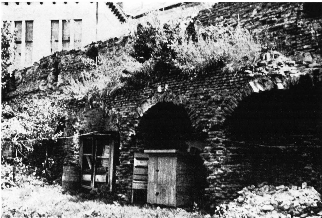
Fig. 10. — Le bourg de Tirgu Mureș; mur d'enceinte antérieur à la restauration.
