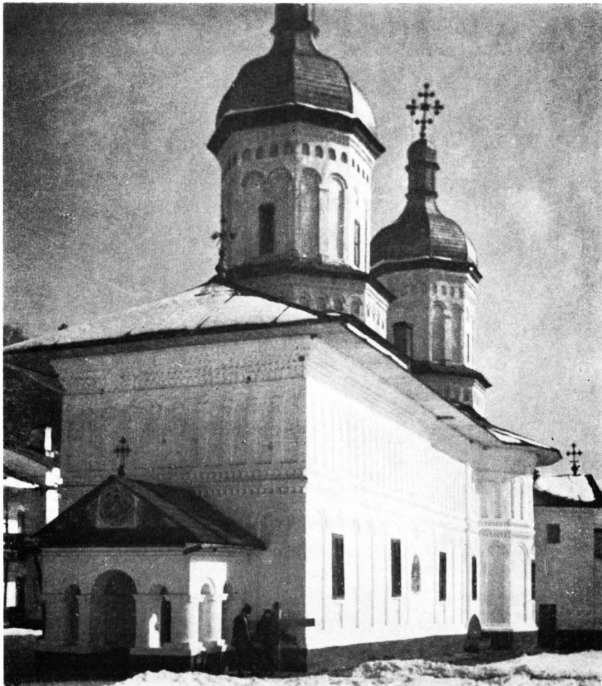
Fig. 12. — L'église du monastère Secu (départ. de Neamț), avant la restauration.
