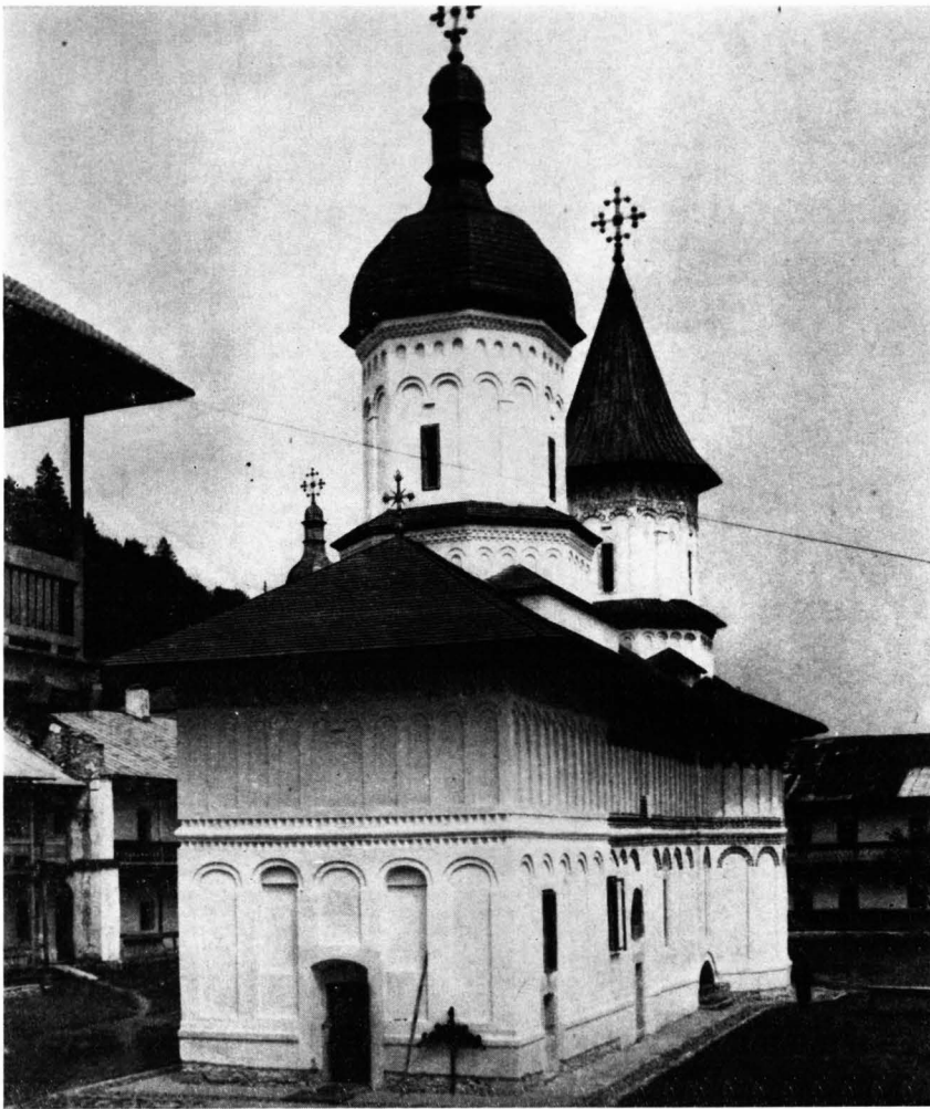
Fig. 13. — L'église du monastère Secu après la restauration de 1966–1972. Le petit portique ouest a été éloigné et les deux phases de construction mises en évidence.
