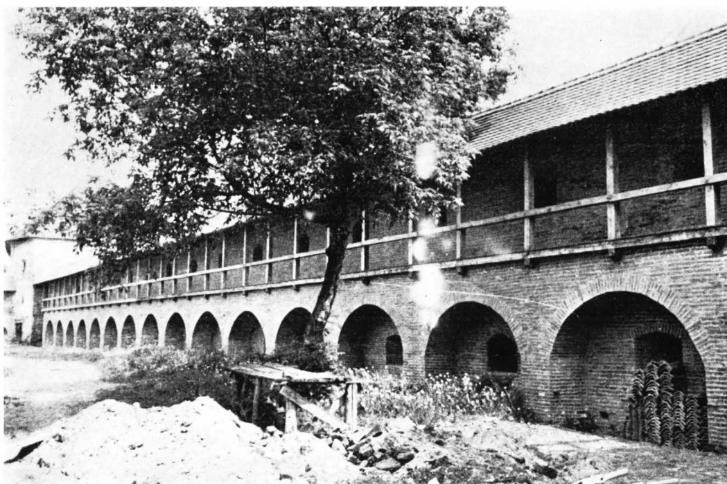
Fig. 11. — Le bourg de Tirgu Mureș; le mur d'enceinte avec le chemin de ronde restauré. Travail en cours.
