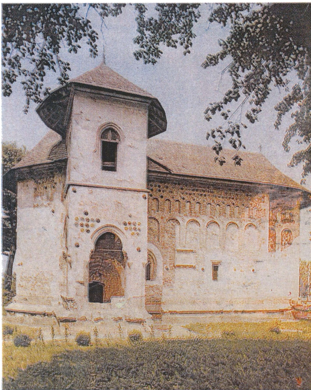
Pl. I. Biserica din Bălinești. Vedere sud (după Corina Popa).
