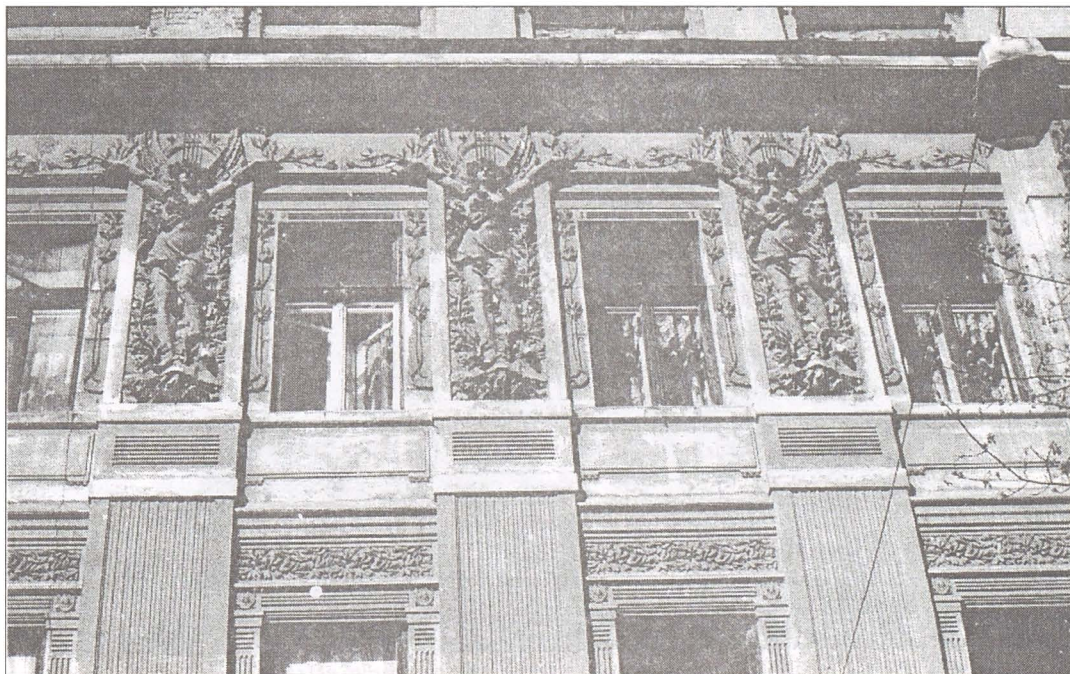
Fig. 4. Imobil din str. 3 August, nr. 5, detaliu cu friză.
