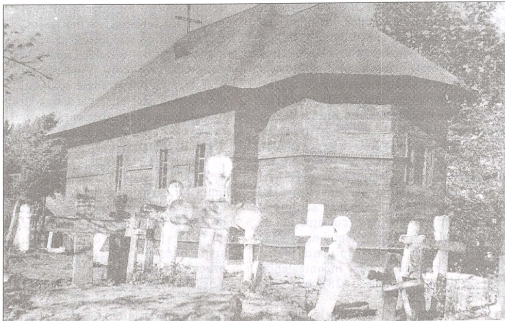
Fig. 5. – Cerțești. Biserica Adormirea Maicii Domnului , după restaurare (Imagine din 1983).
