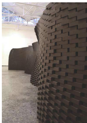
“Structural Oscillations” (2008), Fabio Gramazio, Matthias Kohler, instalație expusă în cadrul Bienalei de Arhitectură de la Veneția – exemplu de asociere între proiectarea algoritmică și asamblarea robotică; sursă imagine: revista Architectural Design 84, no. 3 (Mai/Iunie 2014), p. 59
