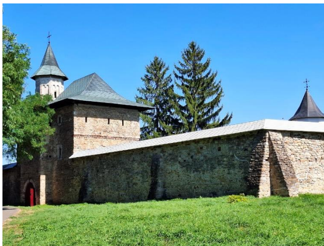
Foto 2: Mănăstirea Zamca - clădirea aflată pe latura de vest a mănăstirii
