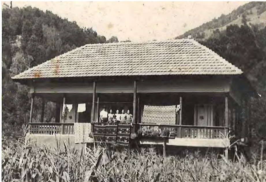
Casa lui N. Lăzărescu din Motru Sec
