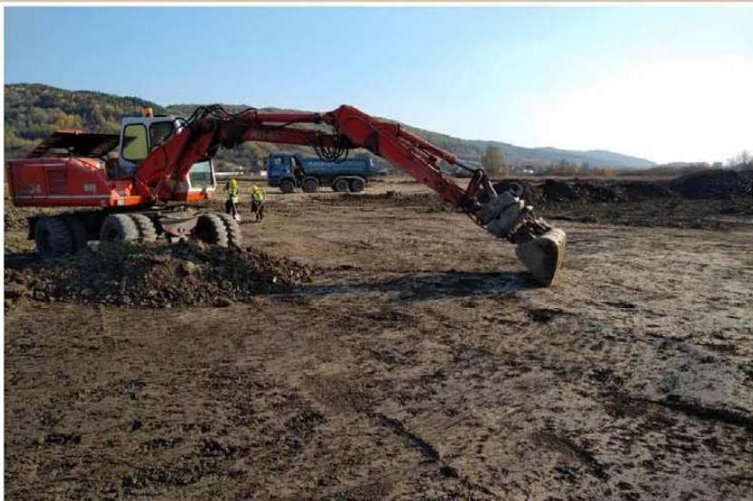
*Foto 3. Decapare planimetrică mecanizată.*
