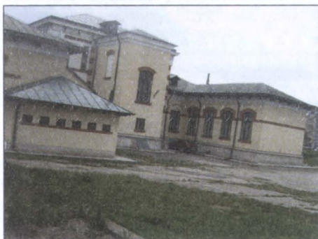
Fațada laterală dreaptă
