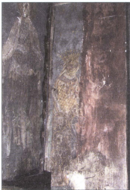
Fig. 12. Naos, tabloul votiv, porțiunea care s-a păstrat după demolarea parțială a peretelui vestic, afectată de reparații grosiere și neglijență.
