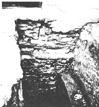
Fig.3 - Fațada sudică a bisericii Popăuți-Botoșani, de jos în sus: talpa fundației; decroșul fundației; zona umplută cu zidărie de sub pragul actualei intrări sudice.
