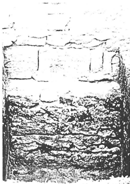
Fig. 2 Biserica Aroneanu; C I, partea superioară a fundației, cu soclu continuu.
