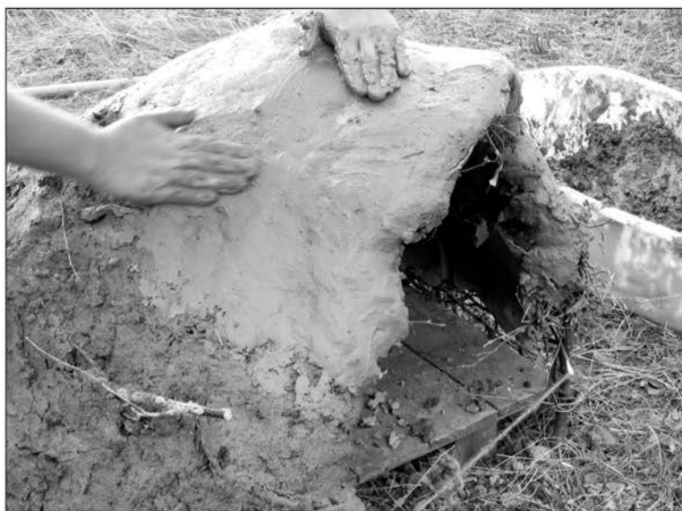
Fig. 9. 1 – Acoperirea suprafeței interioare a cupolei cu lut; 2 – acoperirea și netezirea suprafeței exterioare a cupolei
