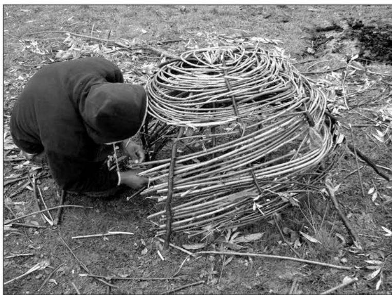
Fig. 8. 1 – Scheletul de lemn a cupolei cuptorului; 2 – structura din nuiele împletite a cupolei
