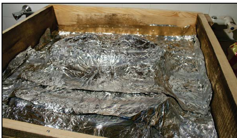
Fig. 12. Acoperirea suprafeței cu un strat izolator de folie de aluminiu (foto: D. Bostan, 2010).
