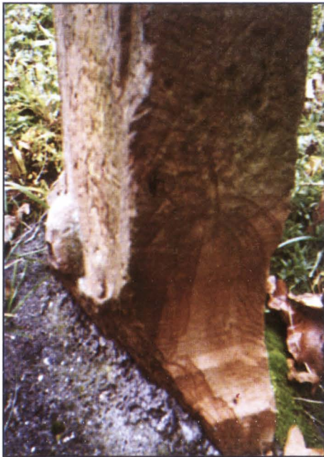
Crucea din stânga-detaliu cu deteriorare de tip mecanic
