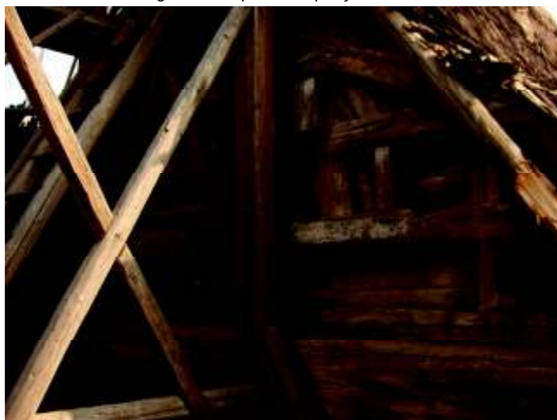
Fig. 24. Scheletul clopotniței, cu sistemul de adosare la peretele vestic.
