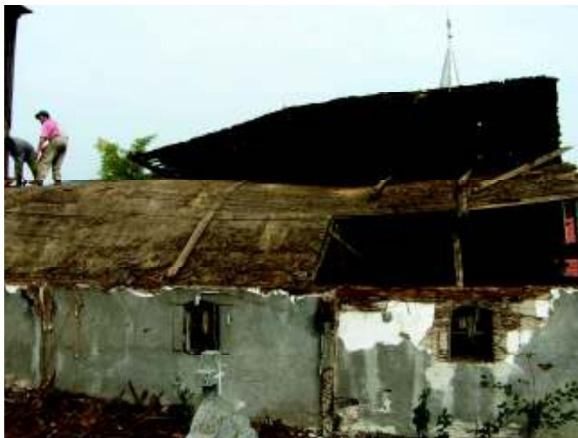
Fig. 22. Decaparea acoperișului navei.
