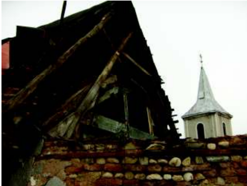
Fig. 21. Imagine după decaparea acoperișului absidei altarului.
