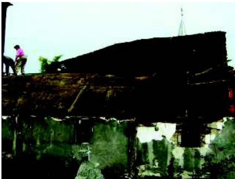
Fig. 22. Decaparea acoperișului navei.
