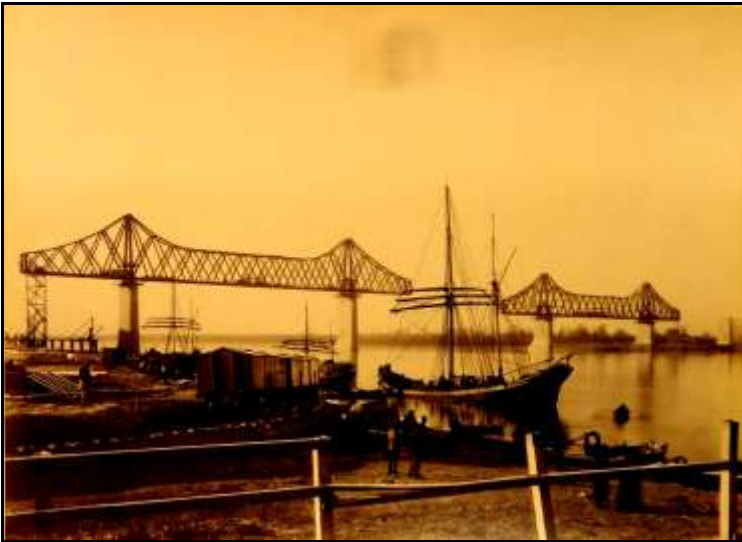
Fig.14. Momentul finalizării execuției celor două grinzi cu zăbrele în consolă.
