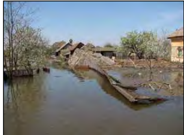
Figure 4. A whole image to notice that the entire village is affected by floods. Figura 4. Imagine de ansamblu în care se observă că întreg satul este afectat de inundații.
