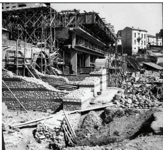
Aspect din timpul lucrărilor de restaurare a Edificiului Roman cu Mozaic de la Tomis și de construcție a clădirii de protecție (1966), Fototeca MINAC, clișeu nr. 9569
