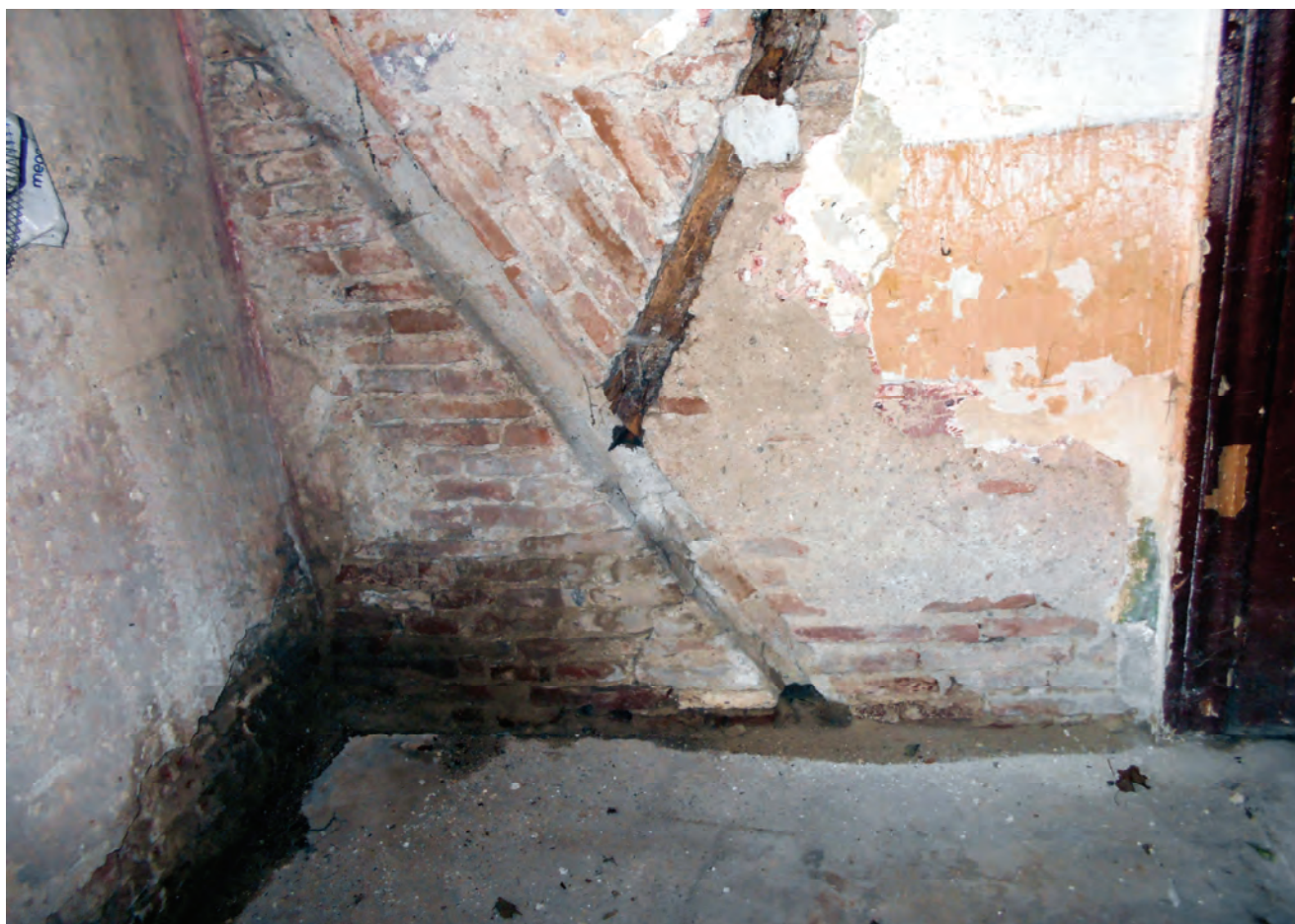
Fig. 4. Casele boierilor Dudescu, clădirea C2. Fragment din zid cu tencuiala căzută. Tiranți de lemn îngropați în cărămidă de secolul al XVIII-lea.
