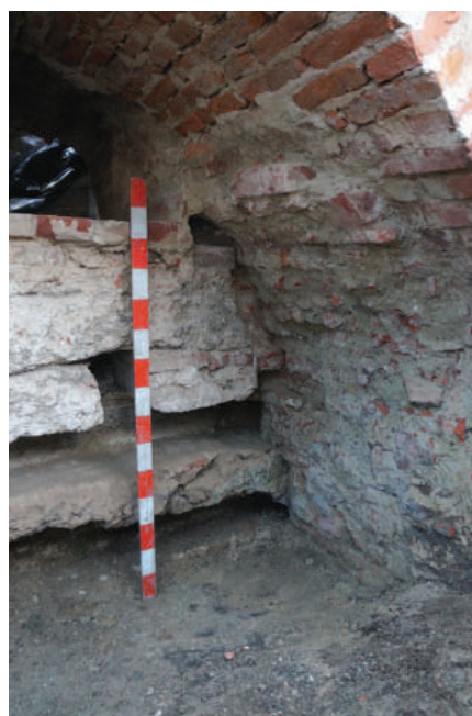
Fig. 46. Legarea structurii de consolidare la partea sudică a arcului zidului vestic al bisericii iezuite. Vedere de ansamblu.
