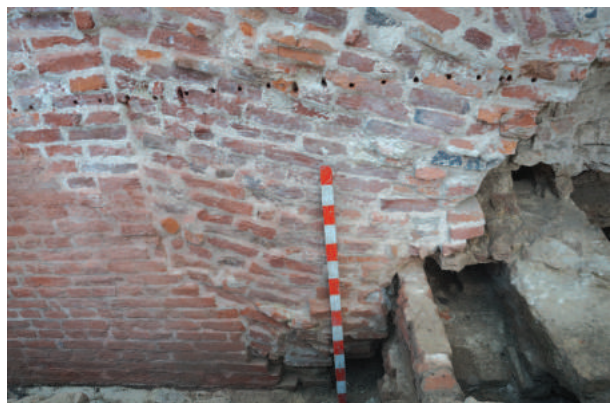
Fig. 43. Legarea arcului la segmentul nordic al zidului vestic al bisericii iezuite. Detaliu.
