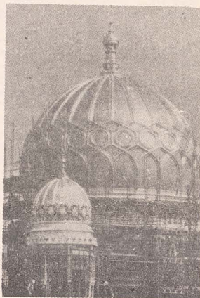
■ Reconstruirea Marii Sinagogi din Berlin situată pe Oranienburger Strasse
