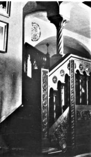
Imobil de raport, str. Dionisie Lupu, arh. Simotta, fotografie din interior. Sursă: Simotta, 1965, cota S II 101, biblioteca UAUIM.
