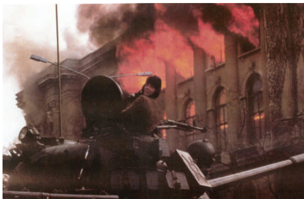
Fig. 2 Incendii din clădirea fostului Palat Regal, decembrie 1989 (sursă - arhiva M.N.A.R.)
