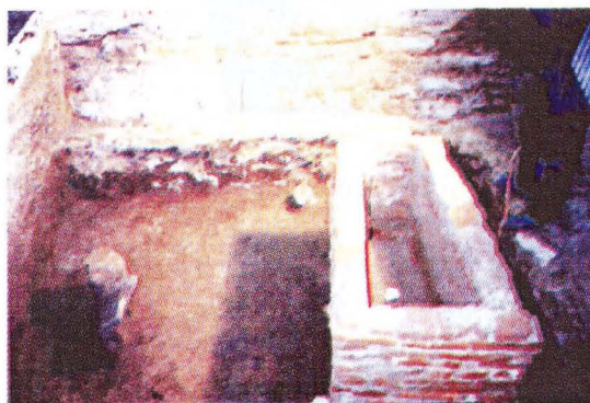
Fig. 14 – Caseta 9: regimul de fundare al bisericii (zidul despărțitor între naos și pronaos)
