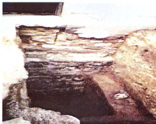
Fig. 17 – Caseta 15: regimul de fundare al bisericii în dreptul intrării sudice, cu urmele părții inferioare a grafului inițial
