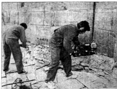
Foto nr.11. Exterior, baza absidei nordice, imagine în timpul intervenției de hidroizolare a zidăriei.
