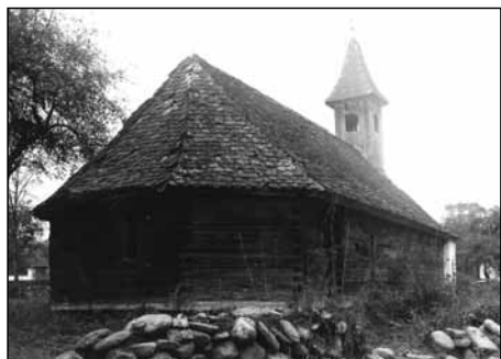
Fig.2 Biserica de lemn din Drăguș, vedere dinspre altar, nord-est, foto arh. H. Teodoru (A.I.N.P., C.M.I., 1540/1933)
