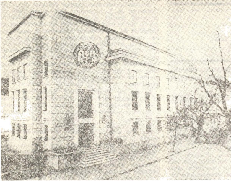
Noul local al Arhivelor Statului din Cluj-Napoca
