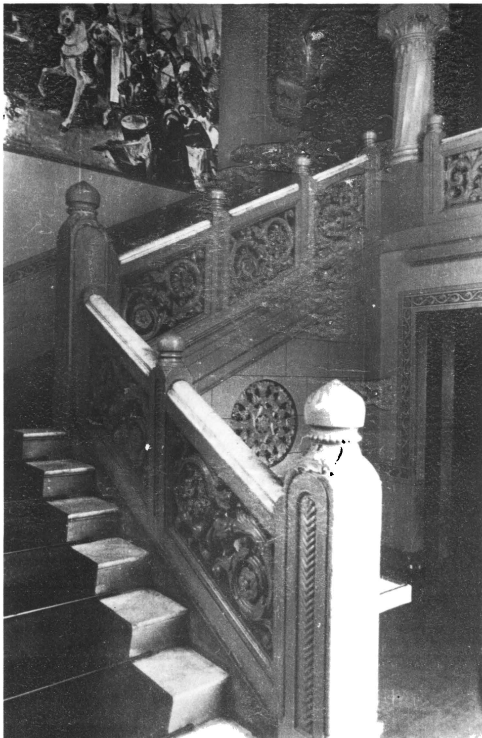
Scara monumentală a sălii Muzeului Arhivelor, distrusă la demolarea Complexului de la Mihai Vodă
