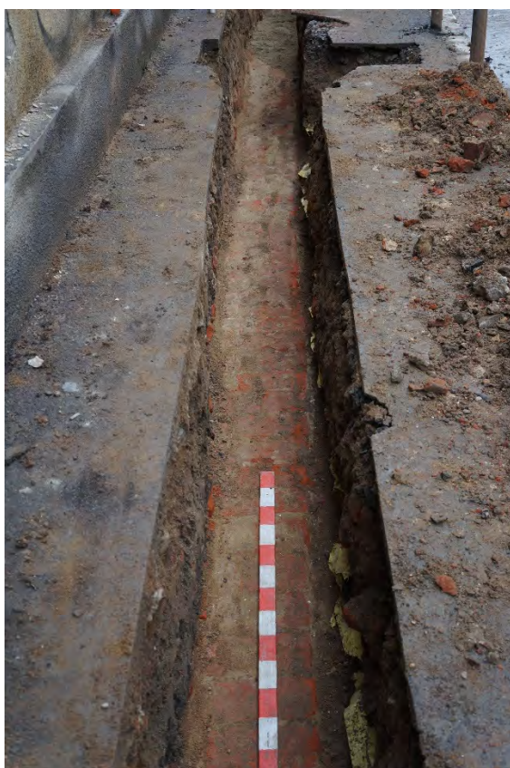
Fig. 7. Șanțul de poziționare a cablurilor cuprins între căminul nr. 2 și poarta de acces în curtea Spitalului Municipal (vedere spre Piața Mărăști). Pe fundul acestuia se poate observa zidul fortificației bastionare.
