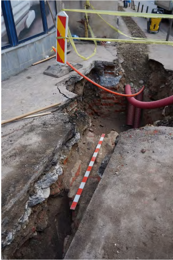
Fig. 5. Zona Căminului nr. 2 (strada G. Dima) cu ruinele zidului fortificației bastionare.
