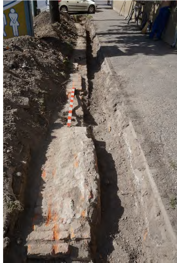
Fig. 16a. Șanțul de poziționare a cablurilor cuprins între Căminul nr. 7 și nr. 8 de pe strada Oituz, unde au fost identificate structuri zidite (vedere dinspre est). Detaliu.
