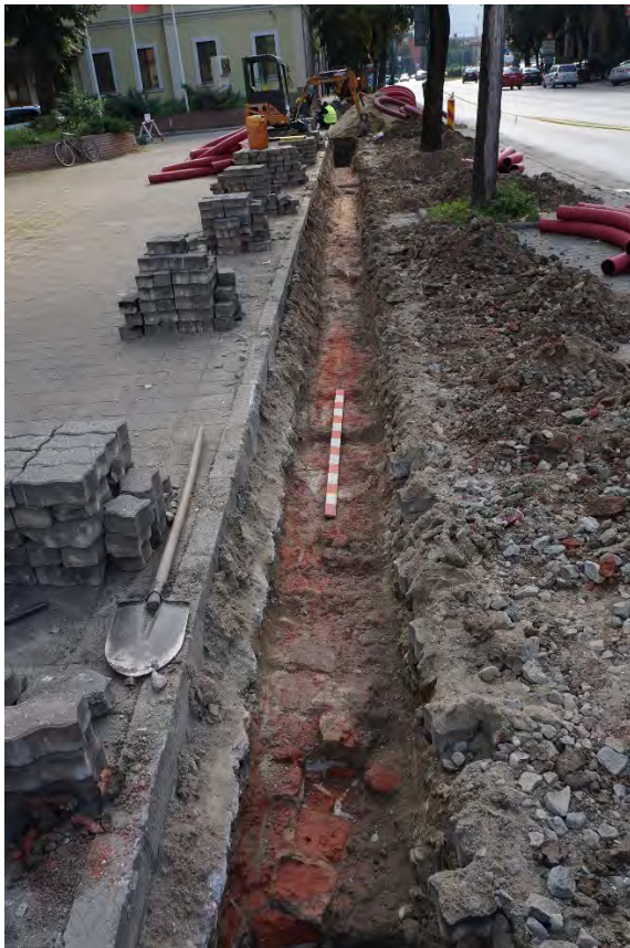
Fig. 14. Șanțul de poziționare a cablurilor cuprins între Căminul nr. 6 și nr. 7 de pe strada Oituz unde au fost identificate structuri ale fortificației bastionare (vedere dinspre vest).
