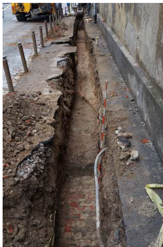
Fig. 8. Șanțul de poziționare a cablurilor cuprins între căminul nr. 2 și poarta de acces în curtea Spitalului Municipal (vedere dinspre Piața Mărăști). Pe fundul acestuia se poate observa zidul fortificației bastionare. În prim plan se observă o structură boltită.
