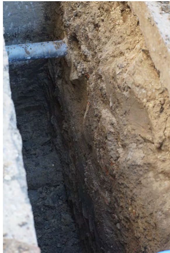
Fig. 11a. Șanțul de poziționare a cablurilor cuprins între structura fortificației bastionare din Piața Mărăști și intrarea Facultății de Arte. Detaliul profilului stratigrafic.
