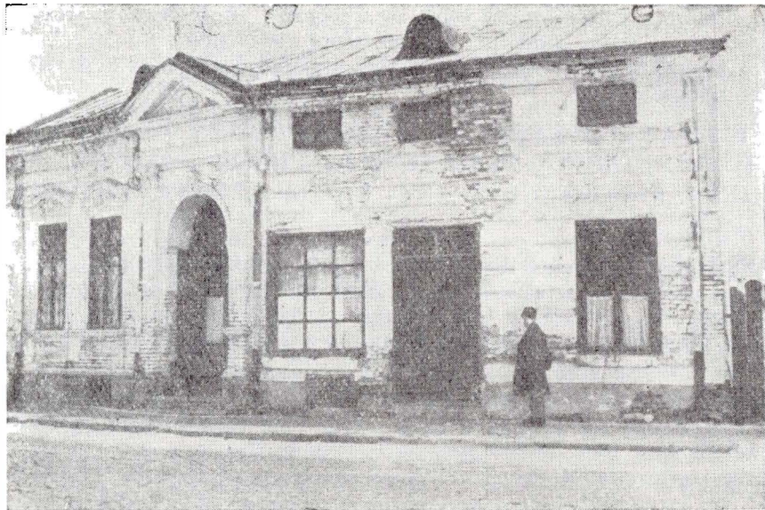
Imobilul din Ploiești, str. V. Roaită, unde a funcționat tipografia „Unirea“
