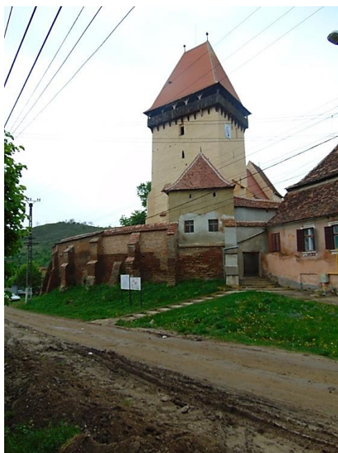
Fig. 3. Biserica medievală fortificată din Ighișu Nou (vedere dinspre zona afectată de lucrări)
