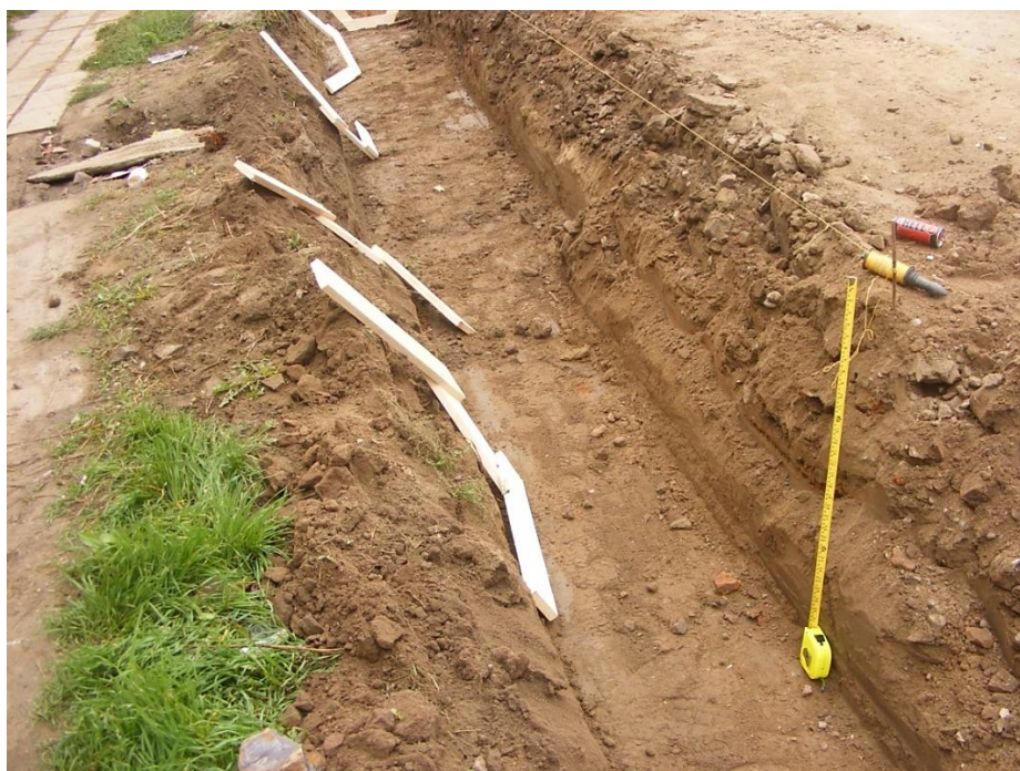
Fig. 8. Imagini cu rigolele excavate mecanic
