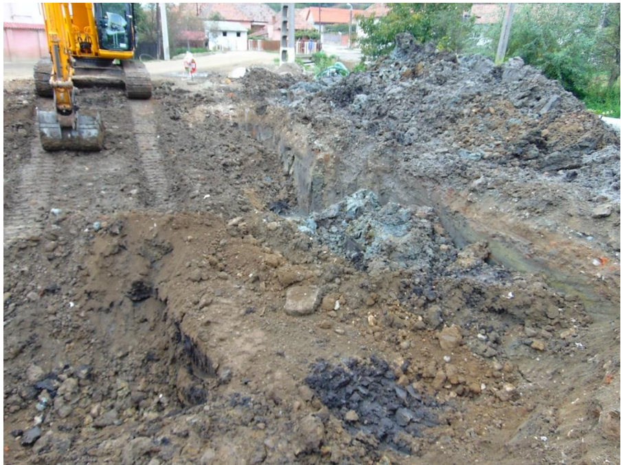
Fig. 12. Imagini din timpul săpării gropii pentru introducerea pompei de apă în piațeta veche
