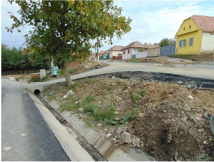
Fig. 13. Intersecția str. Școlii cu str. Mică – locul unde au fost descoperite oase umane, fragmente de chirpici și ceramică aparținând unor construcții moderne
