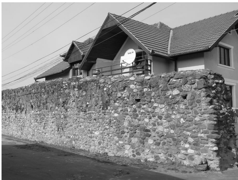
Fig. 5. Vestigii ale curtinelor de pe latura de nord
