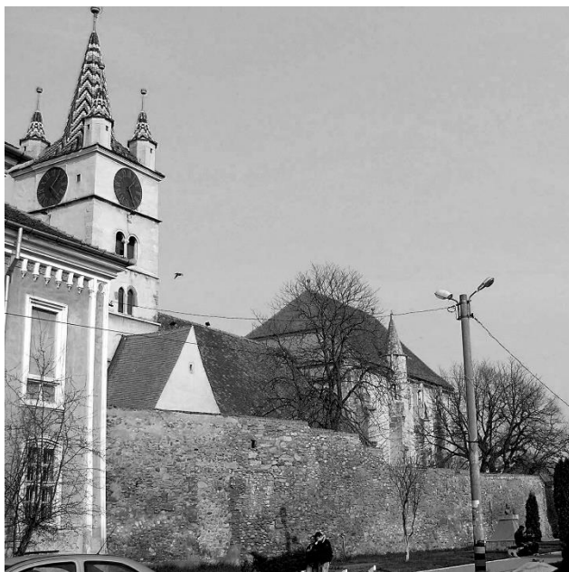
Fig. 2. Zid pe latura sudică a curții bisericii parohiale evanghelice
