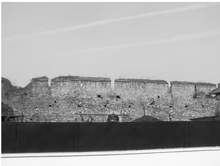
Fig. 17. Partea superioară a curtinelor restaurate de pe latura de sud
