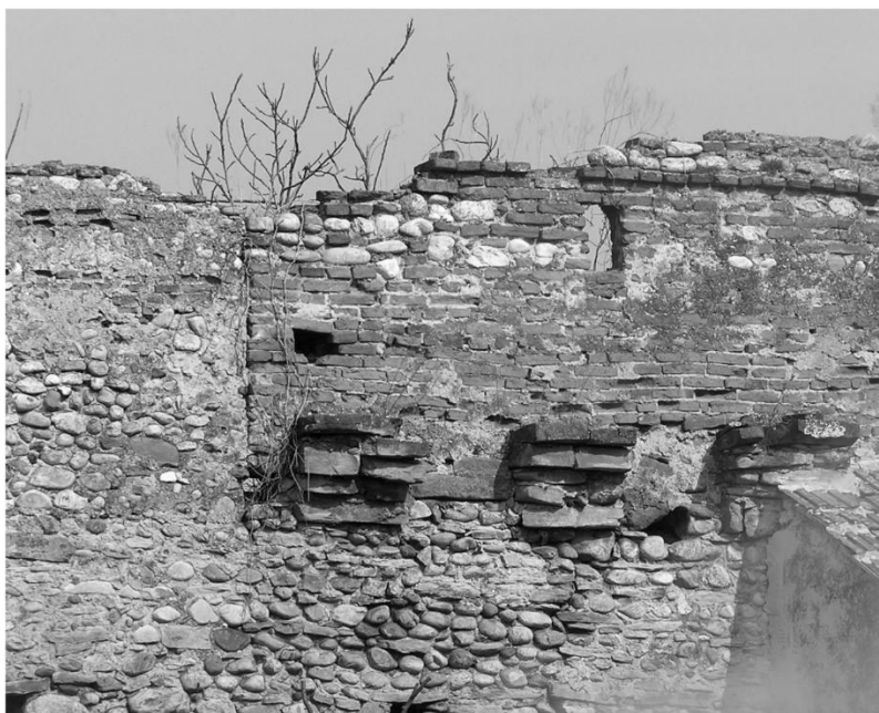
Fig. 6. Curtina de sud, exterior, cu urme de mașiculi
