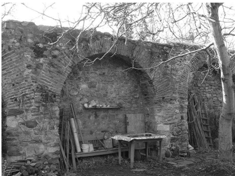
Fig. 7. Curtina de sud, vedere spre interiorul zidului
