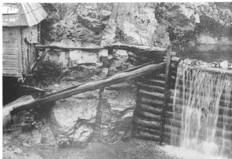
Fig. 20. Zăgazul, stavila și scocul unei mori cu ciutură din Valea Rudărica.
