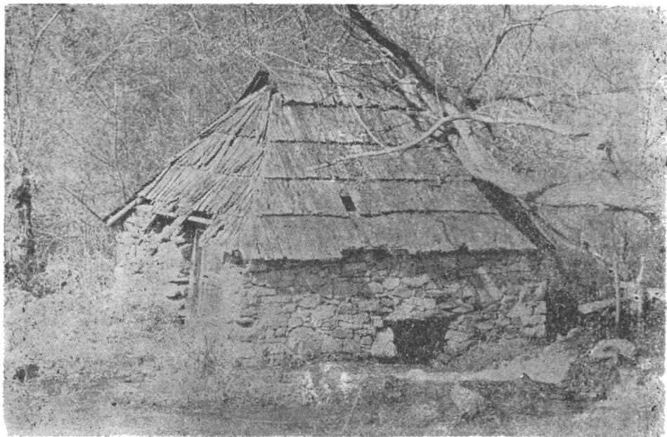
Fig. 2. Variantă constructivă (pereți de piatră) a morii cu ciutură actualmente părăsită (Mehadica) Une variante constructive (murs de pierre) du moulin avec seau (Mehadica).
